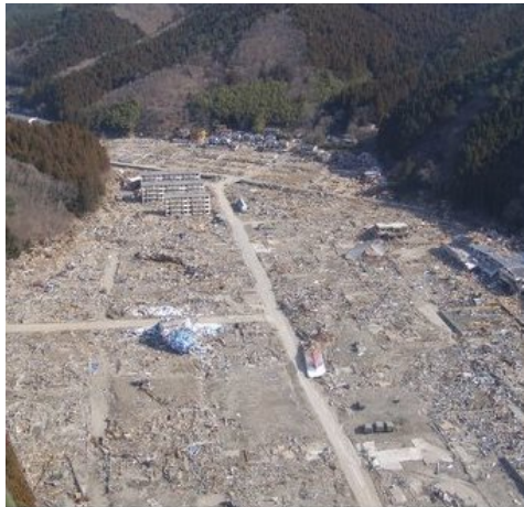
女川町内の家屋の被害状況 (清水町)
