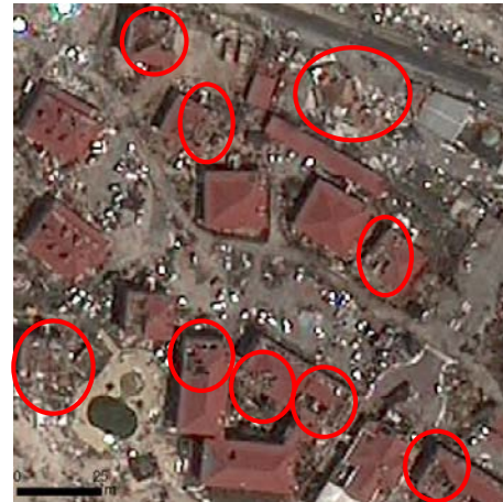
Bâtiments et toits endommagés
