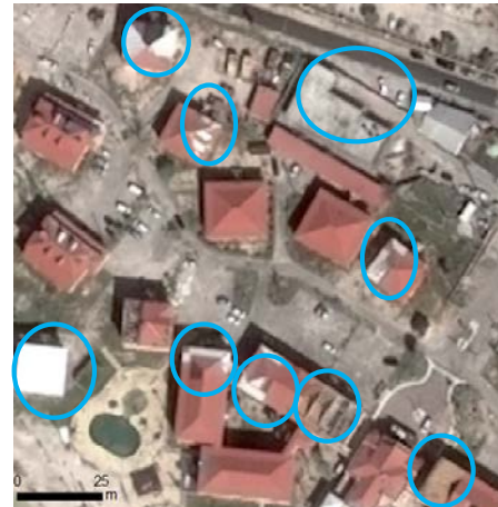
Bâtiments reconstruits ou en cours de reconstruction
